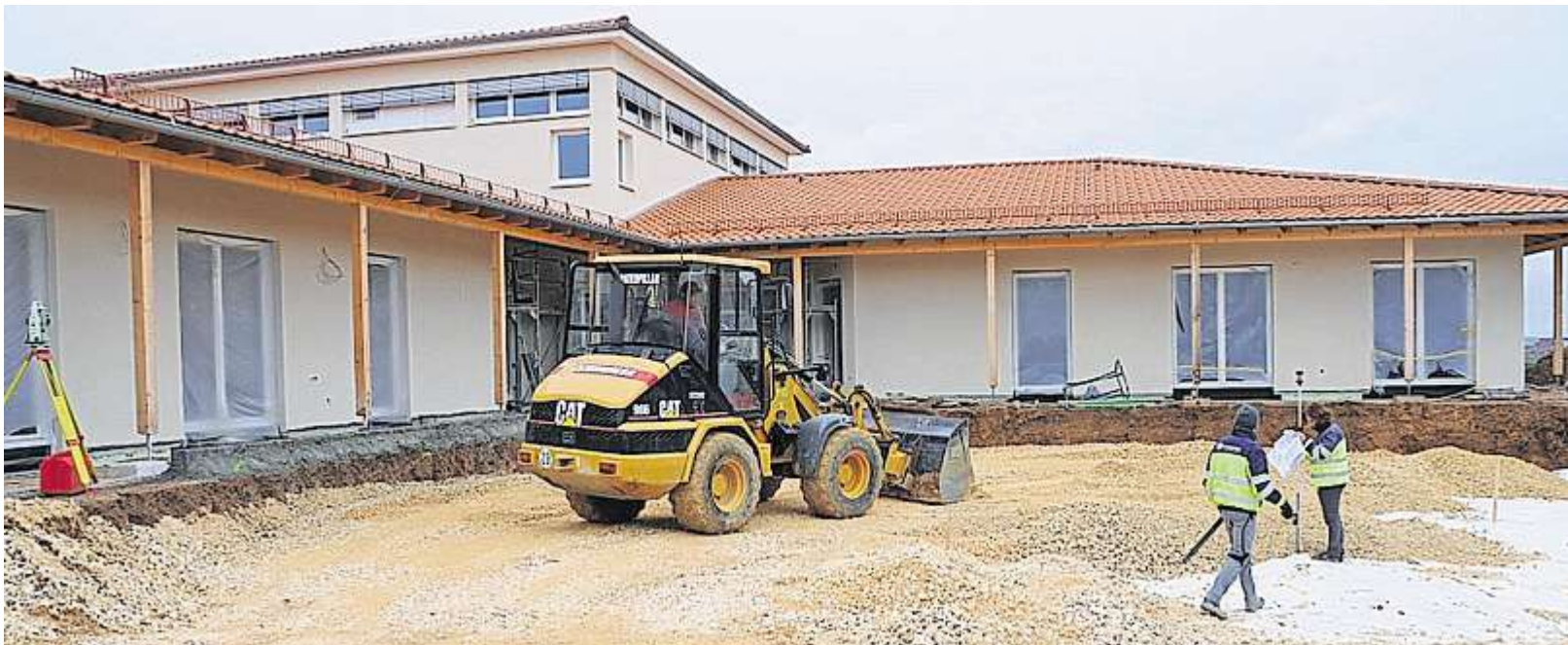
Fleißig gearbeitet wird derzeit auf der Baustelle für das Johannes-Hospiz in Pentling.
